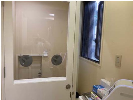
検体採取室（開口部があり外気取込み可能）
